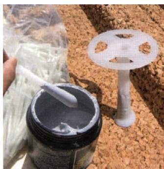
**SIGILLARE ACCURATAMENTE GLI ANCORAGGI CON GUAINA LIQUIDA PER EVITARE INFILTRAZIONI**
