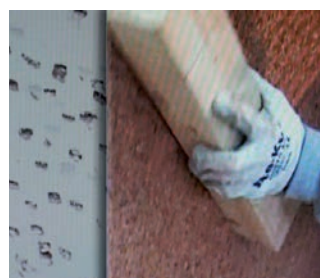
Posa dei pannelli sulla superficie piana. Piccozzare e battere accuratamente
