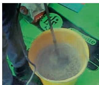
Preparazione del collante con adesivo Geolis 3.5 NHL
