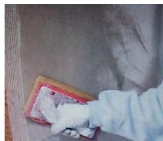
Finitura con intonaco fino con Naturalis 3.5 NHL. Non posare spessori superiori a 2-3 mm
