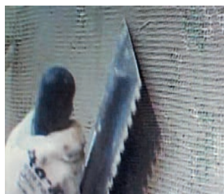
Applicare la rete in fibra con una rasatura a turapori leggera con adesivo Geolis 3.5 NHL
