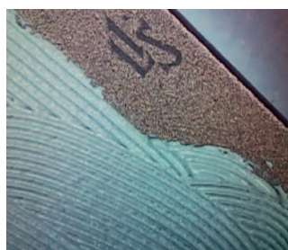
Spalmatura del collante con spatola dentata da 7-10 mm lato grana fine
