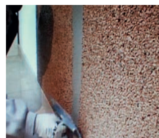
Stuccatura delle giunture con adesivo Geolis 3.5 NHL. Controllare la planarità
